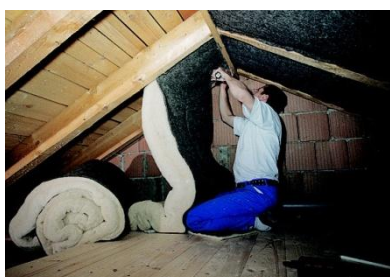
Na-isoleren bestaande bouw
